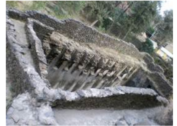
Sistema de recuperació d'aigües pluvials al palau de l'emperador Fasilides, 1632-1667, Gondar, Etiòpia.
